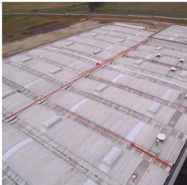
Stato di avanzamento lavori cantiere per posa tubazioni in copertura
